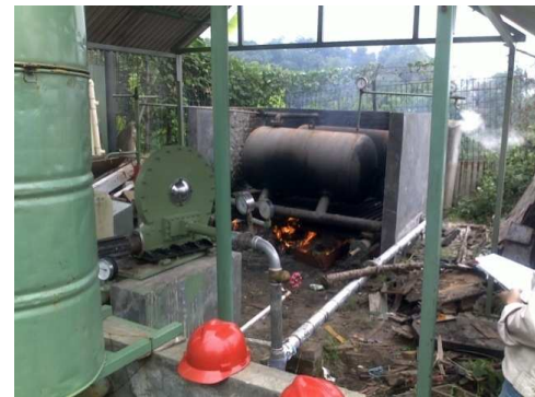
Gambar 9. Instalasi ketel uap dan pengujian operasi
